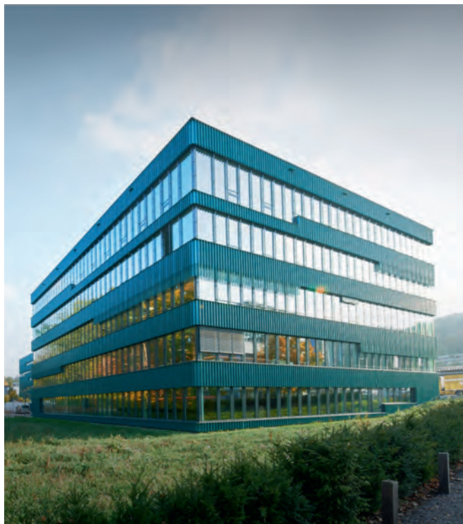
Le bâtiment principal de Brütsch/Rüegger Tools à Urdorf.
