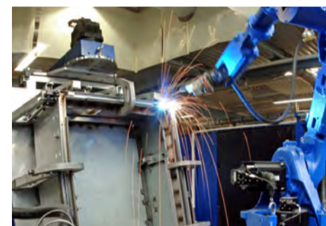
Hochwertige Schweissttechnik: Ein Roboter sorgt für eine hohe, der Bahnnorm entsprechende Qualität.
