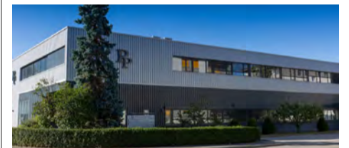
Modern und stilvoll: Das Gebäude der Petitpierre SA.
